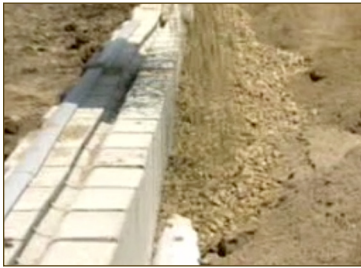
Diagram 7—Backfill
